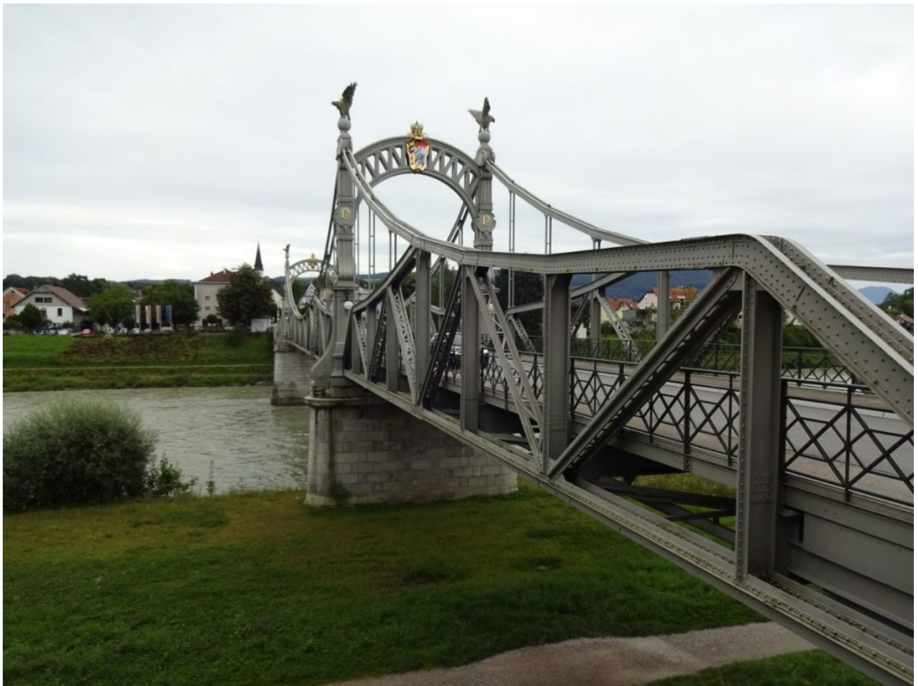
Innbrücke zwischen Laufen und Oberndorf.
