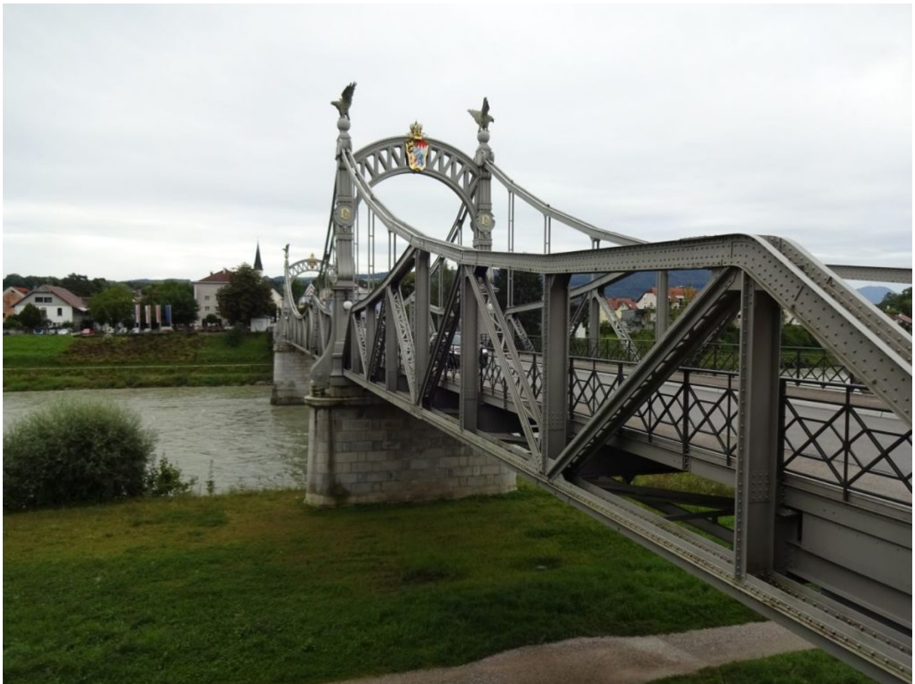
Innbrücke zwischen Laufen und Oberndorf.
