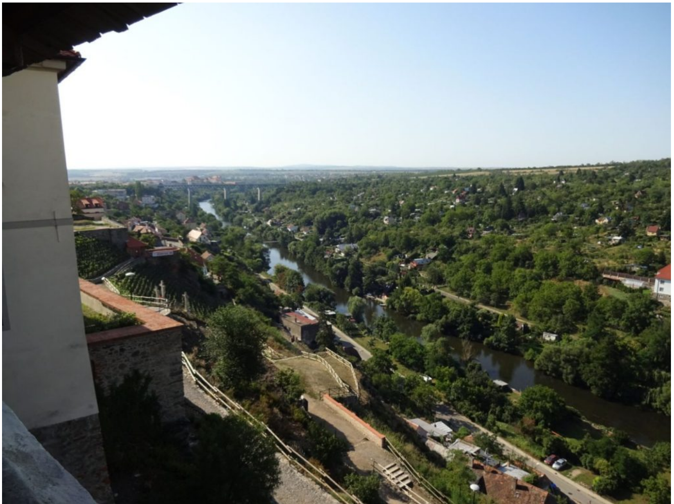
Erster Blick zur Thaya mit dem Eisenbahnviadukt bei Znojmo.
